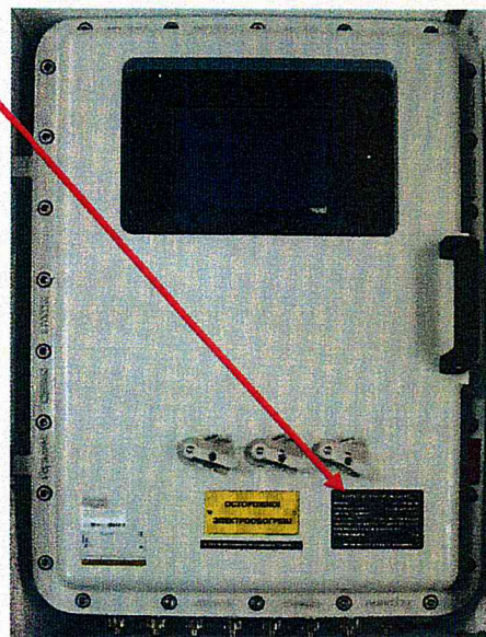
Рисунок 2 – Контроллер во взрывозащищенном шкафу
